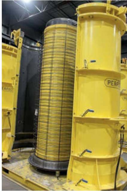
Готовая форма с футеровкой и арматурным каркасом
